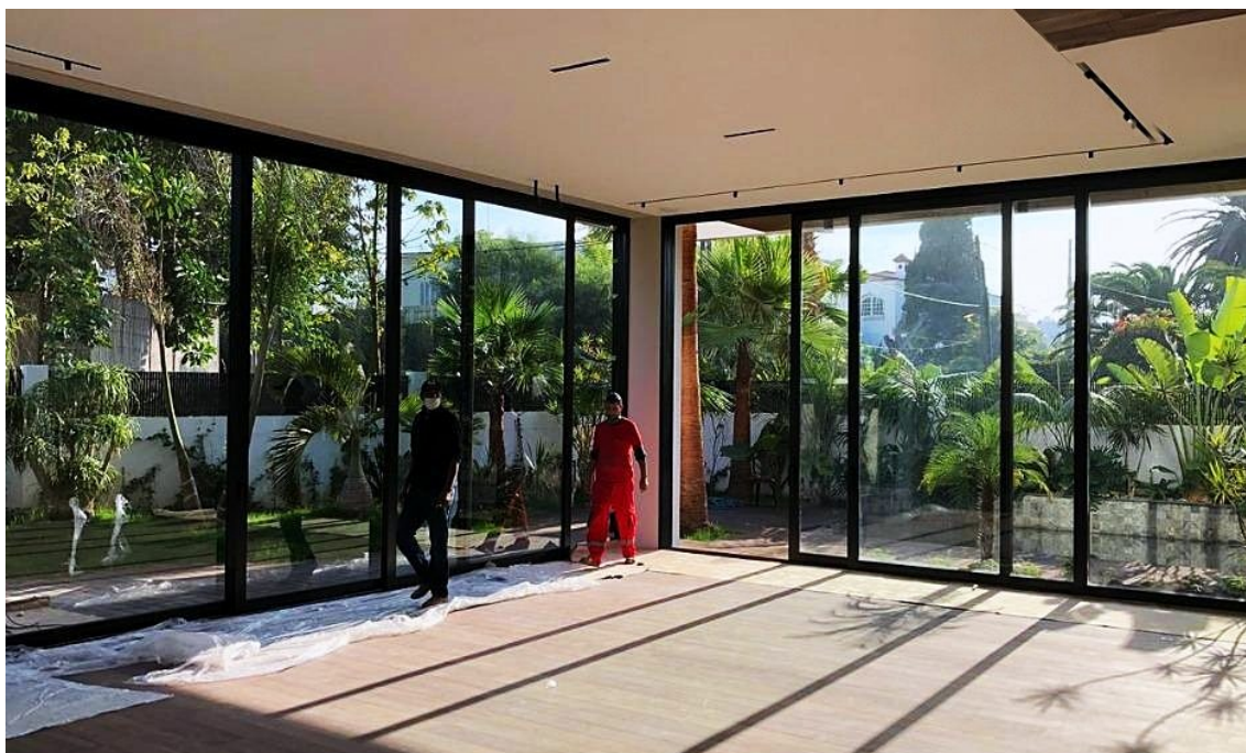
NOS ÉQUIPES À LA RÉCEPTION D'UN CHANTIER
